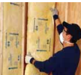
Productos para la construcción
